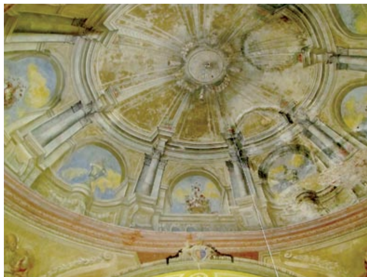
W samym centrum kościoła epileptyczna czasza ukryta w wiązaniu dachowym
