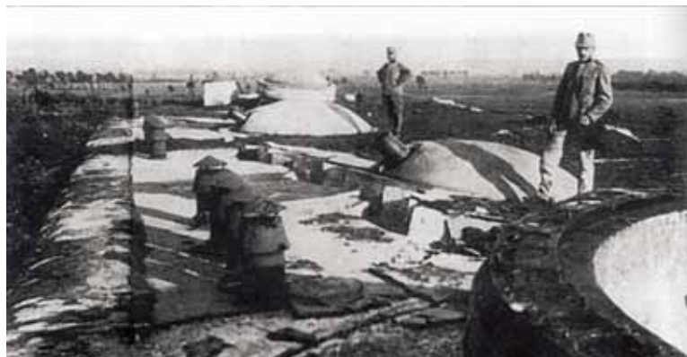
Strop koszar XIII fortu. Widać wyloty luf haubic, strzelających spod betonowego stropu
