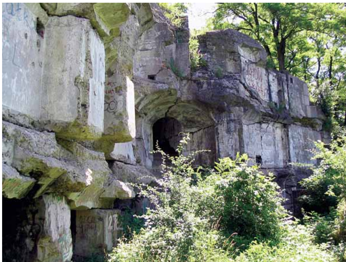
Fort XIII. Wyraźnie widać zarysy stropów, jakie usunęli robotnicy poszukujący stali
